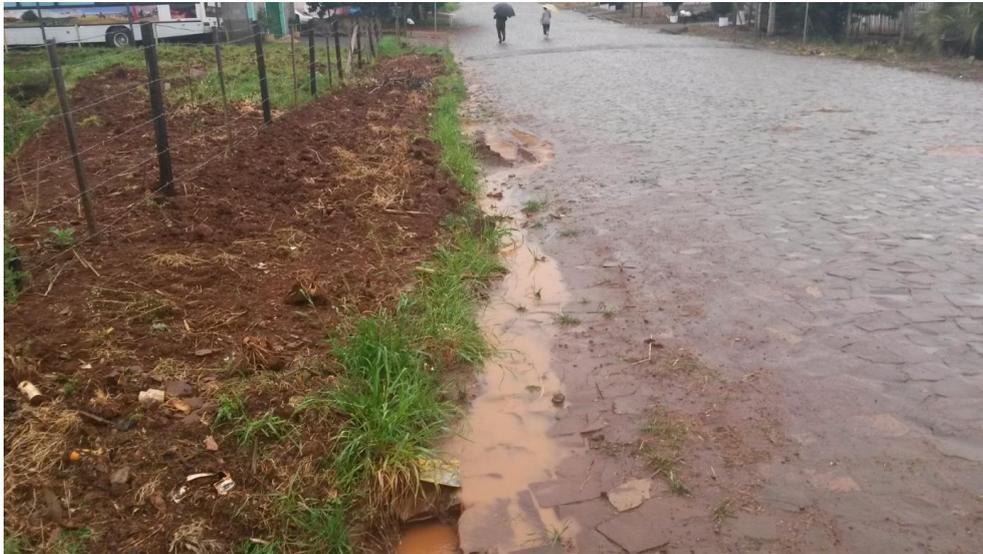
**Figura 12 - Escoamento de águas pluviais sobre a via, em local no qual não foi executado o passeio público.**
