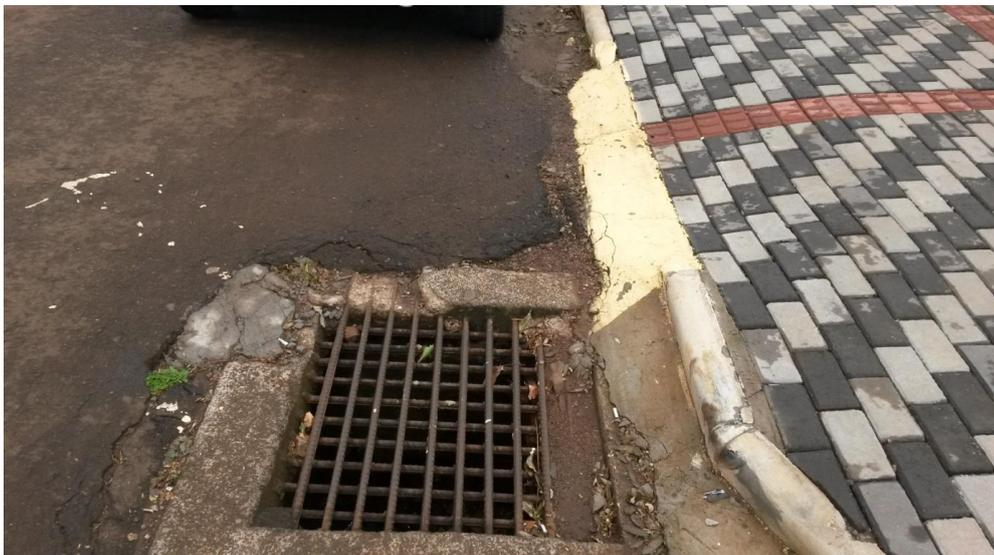
Figura 11 - Grelha para captação das águas pluviais das vias.
